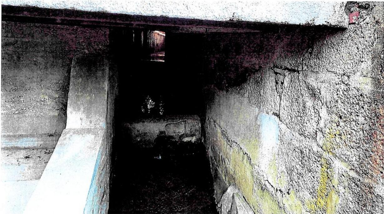
Bild 4: Blick von Unterwasser in den Leerschuss, Decke ca. 1,1 m unter OK (Bereich = Stauziel)
