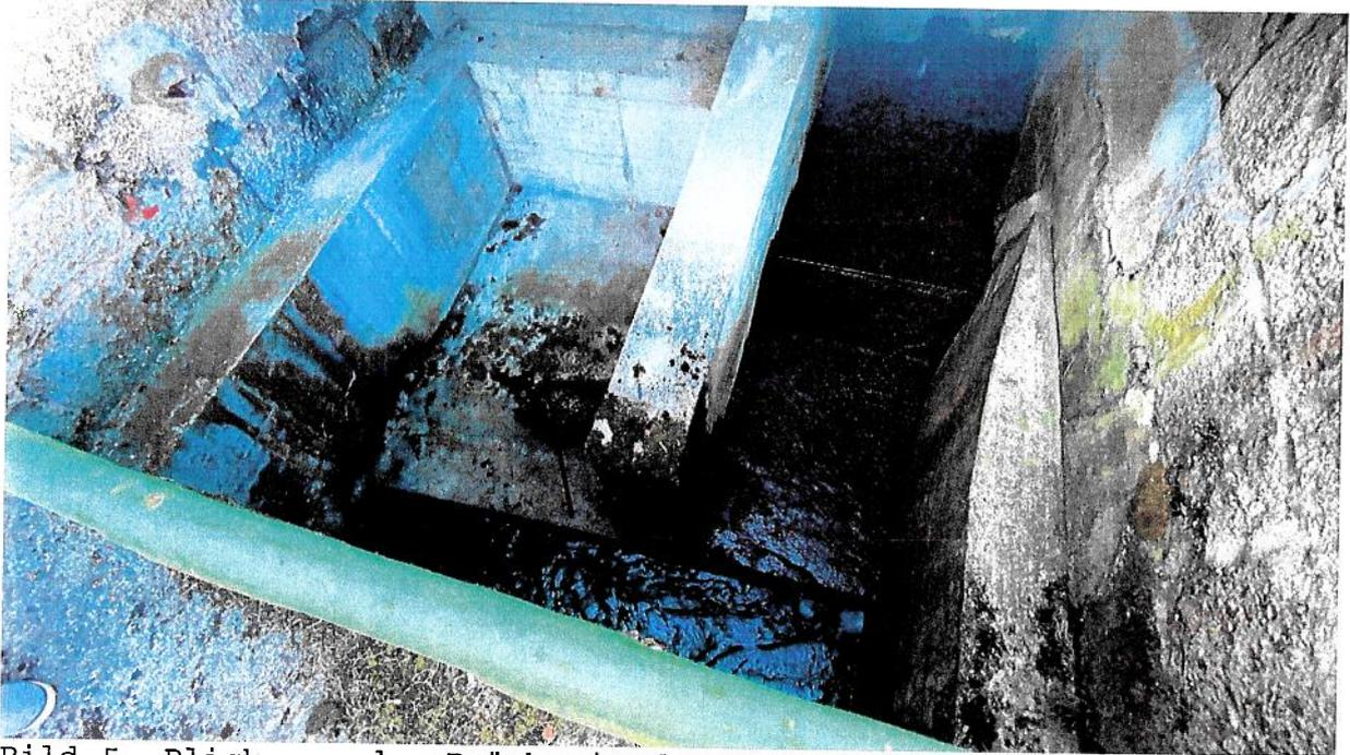
Bild 5: Blick von der Brücke in das Unterwasser, Leerschuss rechts, Turbinenauslauf links im Bild
