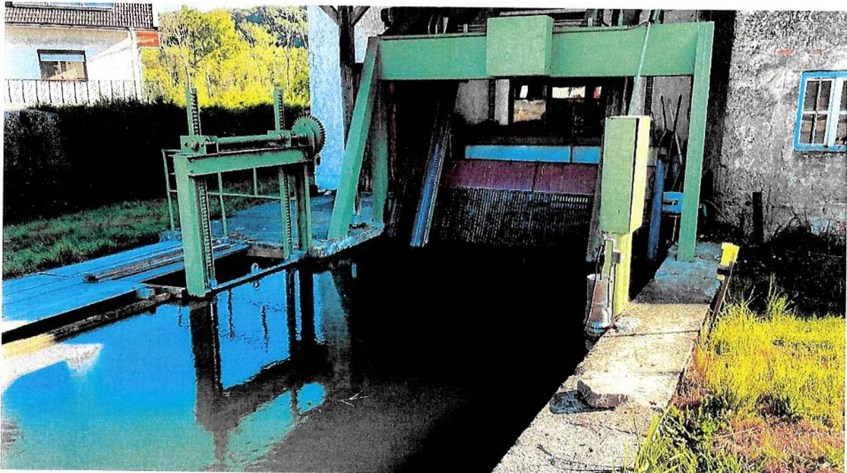
Bild 2: Feinrechen mit Teleskoprechenreiniger, Leerschuss-Schütze links
