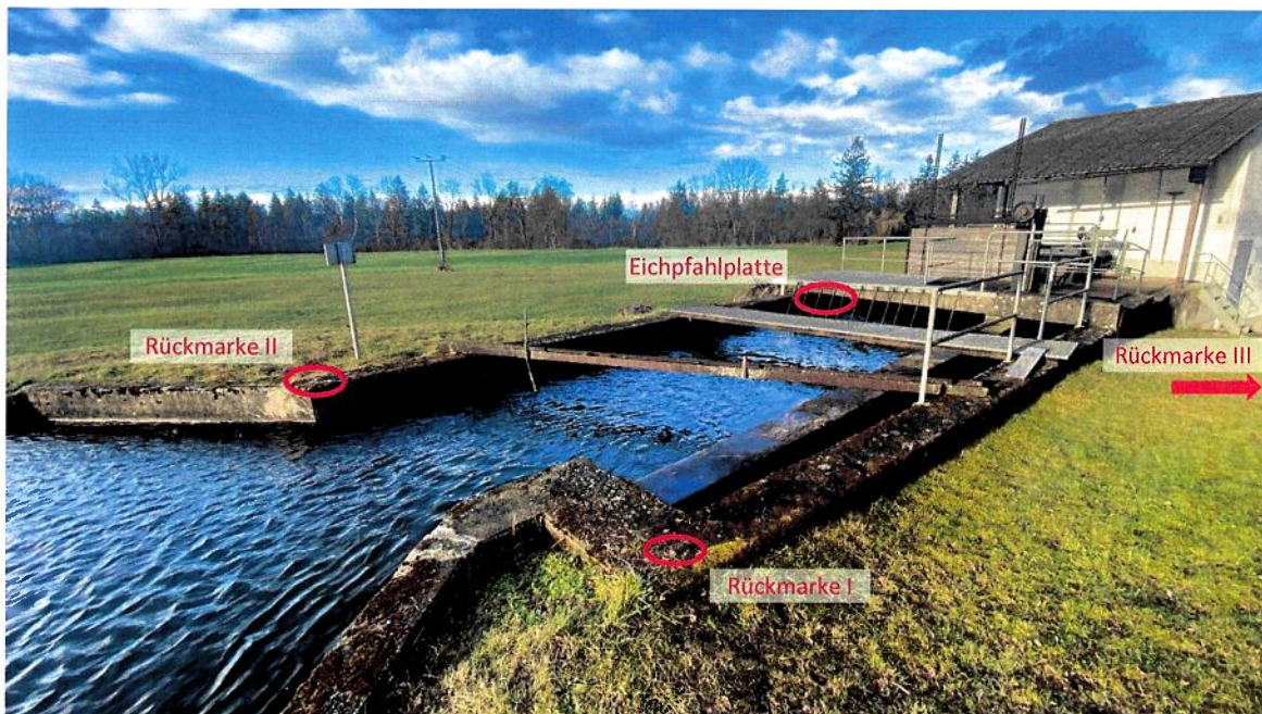
Bild 1: Oberwasserkanal mit Nische für Eichpfahl auf der linken Seite hinter dem Grobrechen, Übereich auf der rechten Seite
