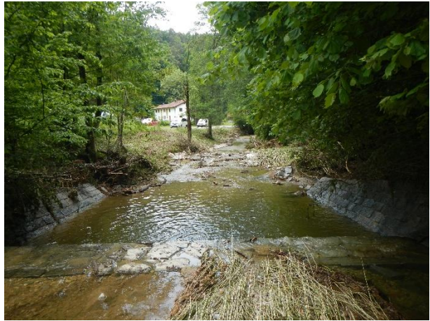
Abbildung 11: Weitbach bei Hundmühl, am ersten Absturz nach Einmündung Hauzinger Bach Blick nach Unterstrom (07.06.2021)
