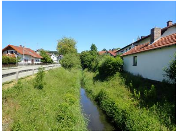
Abbildung 15: Weitbach im Ortsbereich Bahnhof- straße
