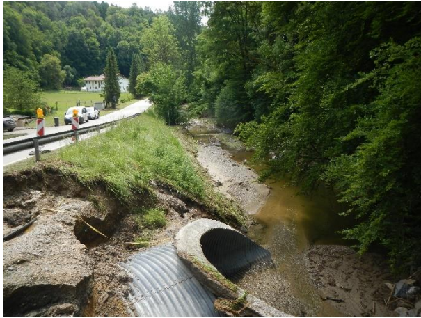
Abbildung 10: Verlauf Weitbach bei Hundmühl, Blick nach Unterstrom (07.06.2021, nach Hochwasser)
