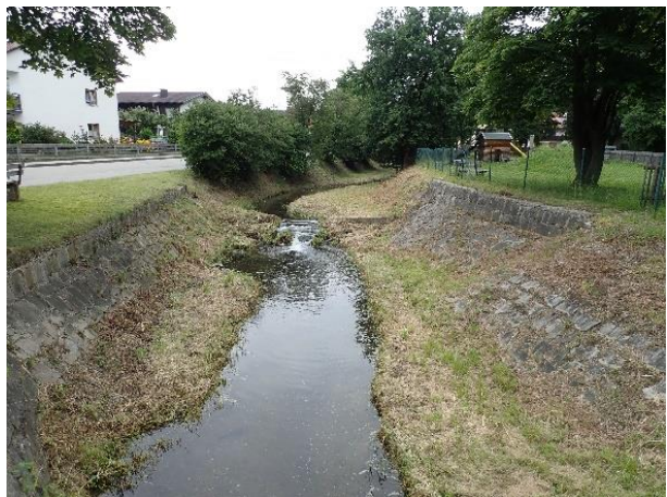
Abbildung 13: gemauerte Uferböschungen Höhe Spielplatz
