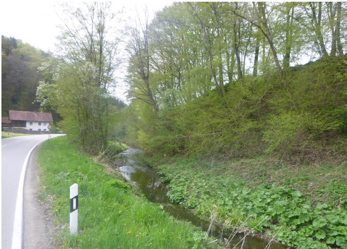
Abb. (5): Untersuchte Böschung im rechten Bildbereich, etwa auf Höhe von RQ1 (10.05.21)
