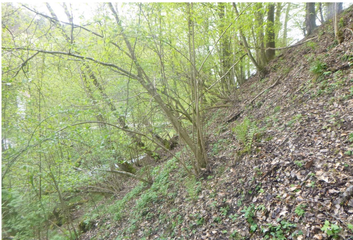
Abb. (6): Oberer Bereich der untersuchten Böschung (10.05.21)
