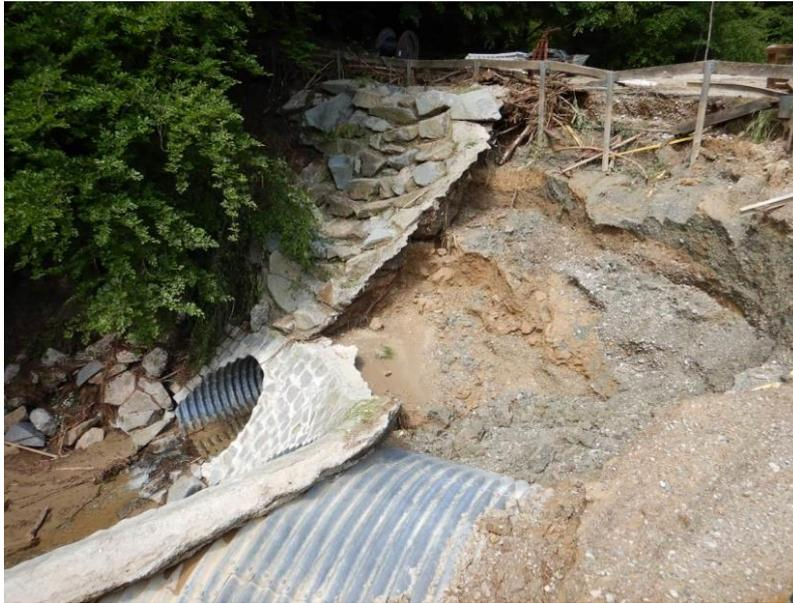
Abbildung 4.14: Die Böschungseinbindungen des Wellblechdurchlasses (Hauzinger Bach und Weitbach) wurden durch die überströmenden Hochwassermassen stark beschädigt (Gunz, 2021)
