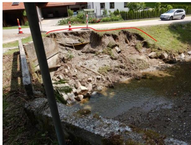
*Abbildung 4.23: Anschlaglinie unterhalb der Landreisstraße – Brücke im Bereich Weinzierl (Gunz 2021)*      *Abbildung 4.24: Erhebliche Erosionschäden unterwasserseitig der Brücke (Gunz 2021)*
