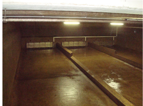
Bild 8: Stauvolumen mit Spüleinrichtung
