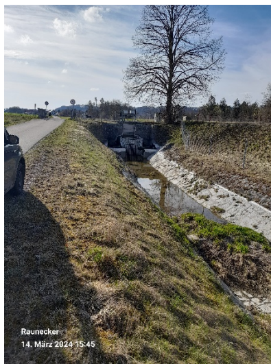
Bild 30: Ableitungsbauwerk für den Walder Mühlbach in den Umleitungsgraben
