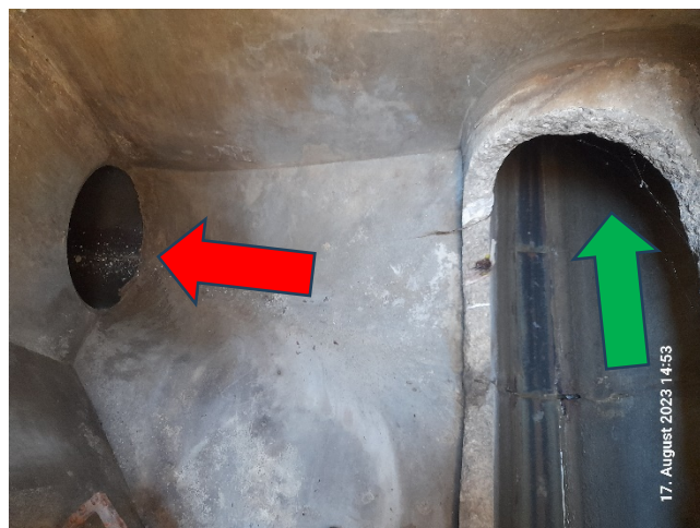
Bild 23: Verzweigung Kantstraße - Kanal nachträglich geöffnet
