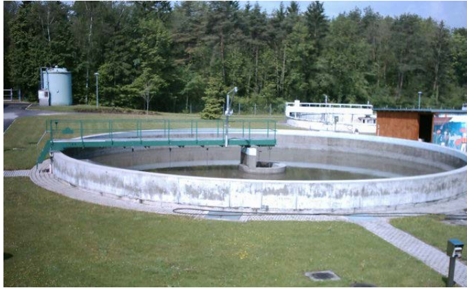
Bild 19: Becken 7a - ehem. Nachklärbecken der Tropfkörperanlage
