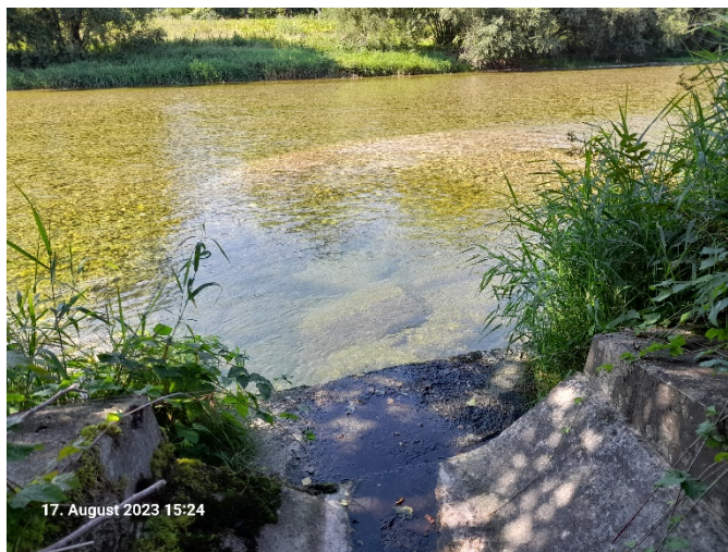
Bild 9: Auslaufbauwerk in die Alz
