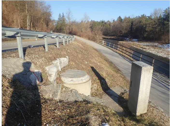
Bild 3: Zugang zum Bauwerk, Lage an der Alz
