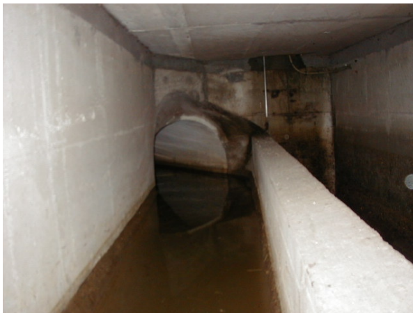
Bild 13: Blick in den Ablaufkanal zum Vorfluter
