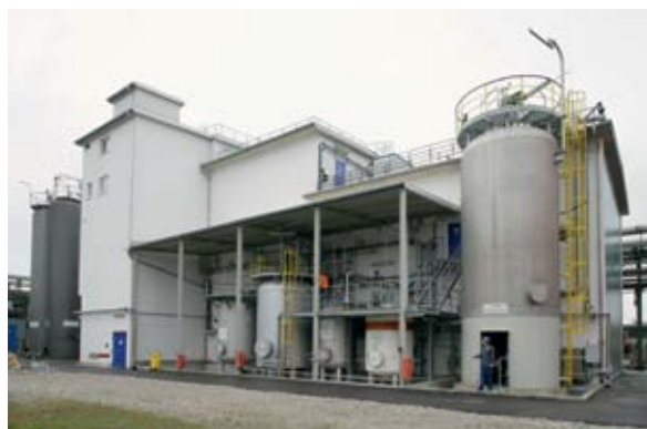
Die Dyneon GmbH entwickelte und baute als erstes Unternehmen weltweit eine Rückhalte- und Recyclinganlage für PFOA.
