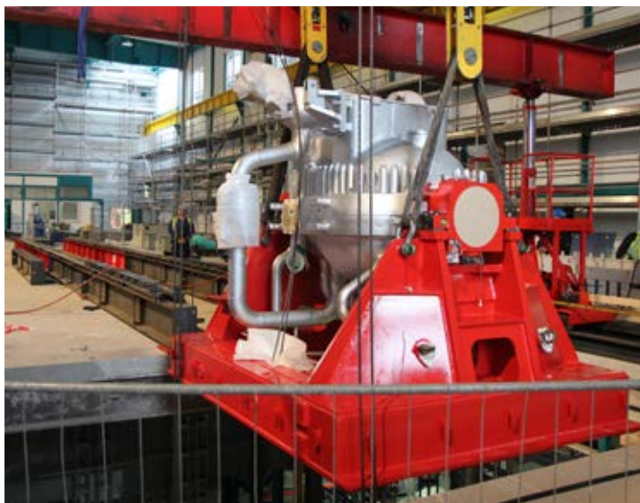
Einbau Dampfturbine
