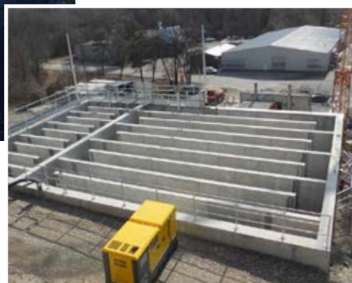
Bauwerk mit zwei Verzögerungsbecken
