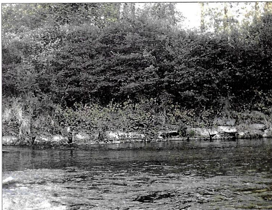
Bild 12: Uferverbau mit Blocksteinen bei F-km 10,70
