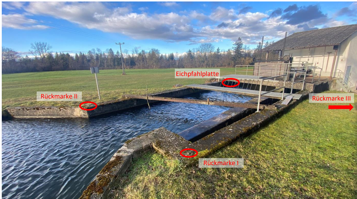
Bild 1: Oberwasserkanal mit Nische für Eichpfahl auf der linken Seite hinter dem Grobrechen, Übereich auf der rechten Seite
