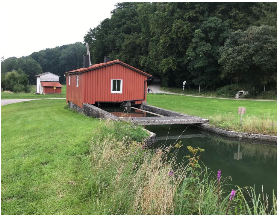
Bild 1: Oberwasserkanal, Einlaufbauwerk, Turbinenhaus mit dem unter der Strasse verlaufenden Düker und Leerschuss
