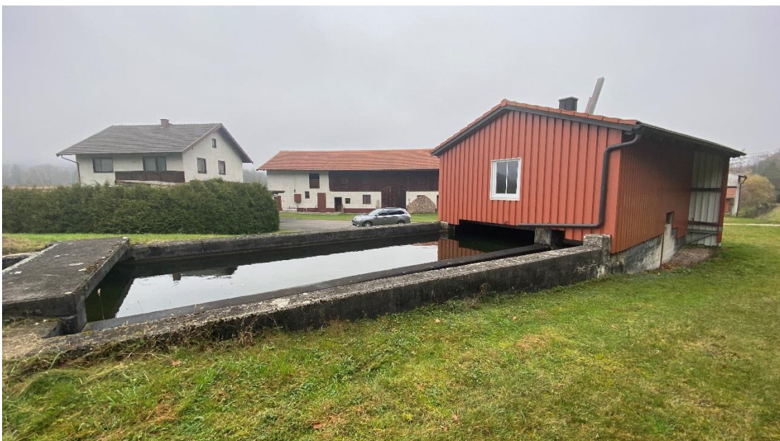
Bild 2: Einlaufbauwerk mit Einhausung der Rechenanlage, Übereich im Vordergrund, Eichpfahl in der Nische links
