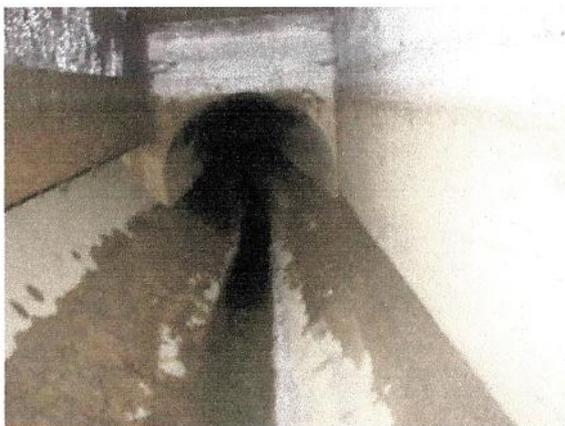
Bild 17: Stauraumkanal, Zulauf zum Trennbauwerk
