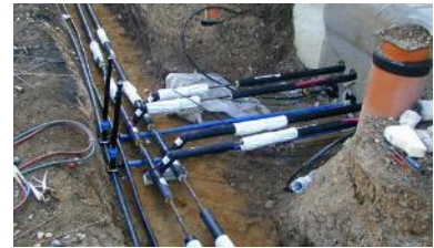
Abbildung 180: Anbindung an ein Fernwärmenetz; Dürener Rohrleitungsbau GmbH
