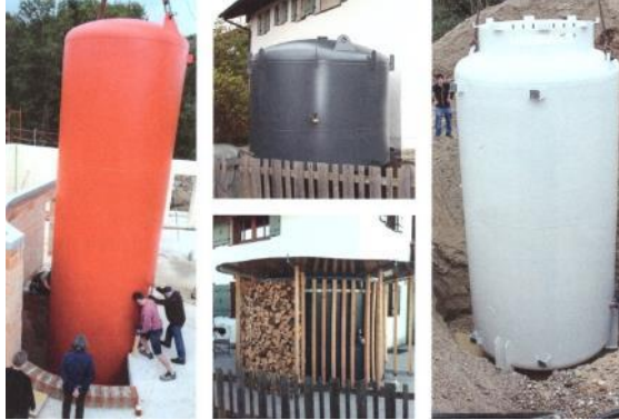
Abbildung 139: Installation Vakuumpufferspeicher
