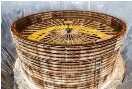
Abbildung 127: Rohrleitungen eines Eisspeichers, Fa. Viessmann
