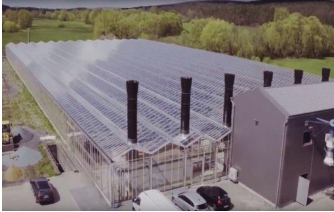
Abbildung 77: Solarthermische Klärschlamm-trocknungs-an-lage für 300.000 Haushalte in Bayreuth
