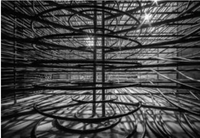
Abbildung 175: Anordnung des Wärmetauschers im Eisspeicher, Fa. Viessmann
