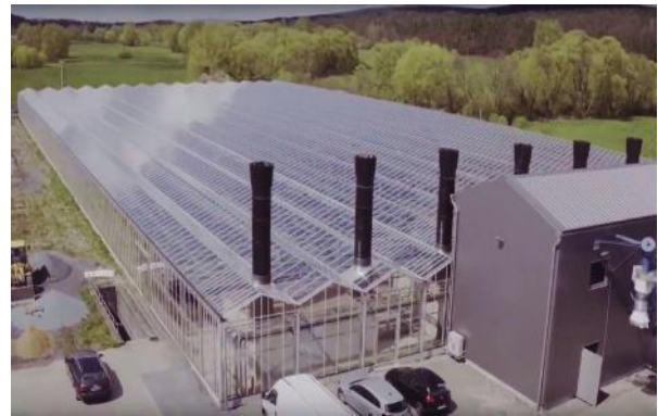
Abbildung 159: Solare Klärschlamm-trocknung in Bayreuth für 300.000 EW, bestehend aus 15 Trocknungshallen, mit ca. 8.000 m 2 Gesamtfläche; (HUBER SE 2017)
