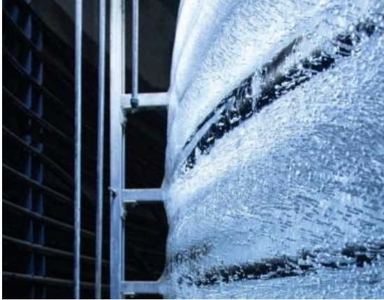
Abbildung 182: Gefrorenes Wasser im Betonbehälter, Fa. Viessmann
