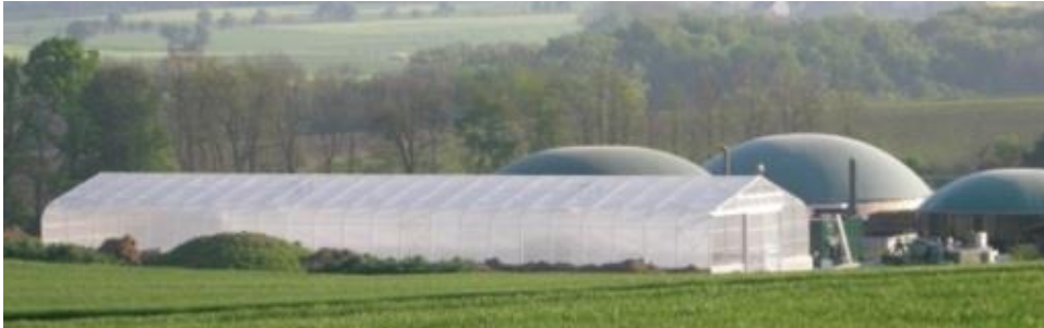
Abbildung 151: Externe Wärmeunterstützung aus einer Biogasanlage, für eine Gärrest-Trocknungshalle; Fa. Thermosystems GmbH
