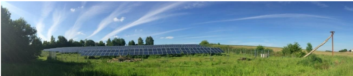
Abbildung 201: Solarpark der Erzeugergemeinschaft für Energie in Bayern eG, mit 950 kW Leistung
