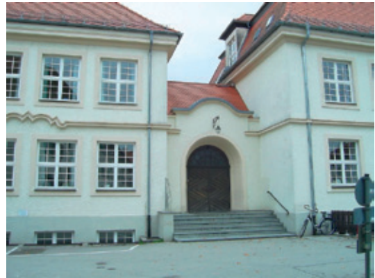
Grundschulgebäude, Janischplatz 1, 84518 Garching
