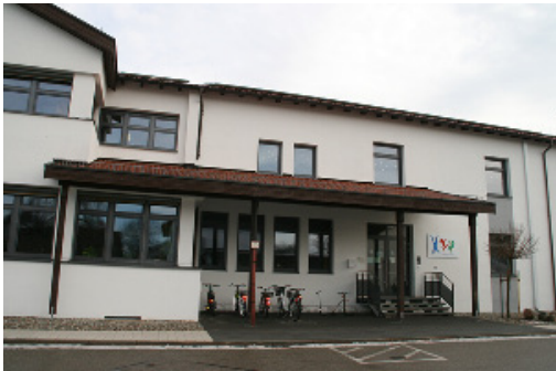
Schulhaus Emmerting, Untere Dorfstraße 3
