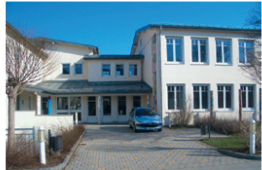
Schulhaus Mehring, Scheibelbergstraße 4
