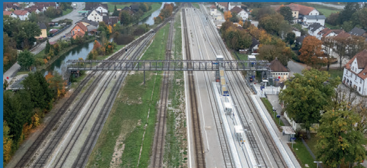
Bahnhof Garching a. d. Alz - Barrierefrei - mit neuen Bahnsteigen und Fußgängerübergang mit Aufzügen
