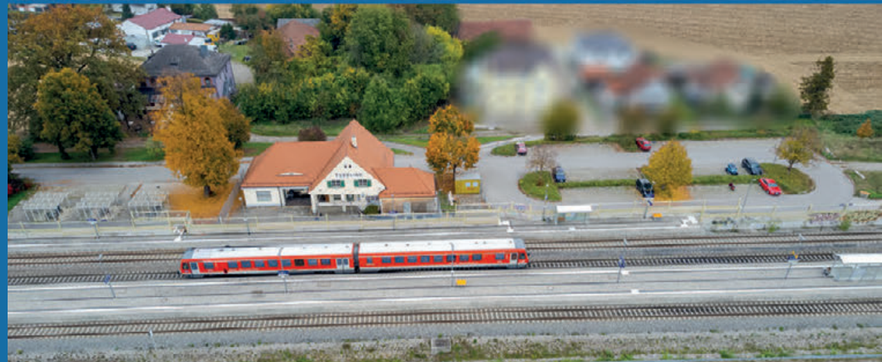
Bahnhof Tüßling mit neuen Hochbahnsteigen und Fußgängerunterführung
